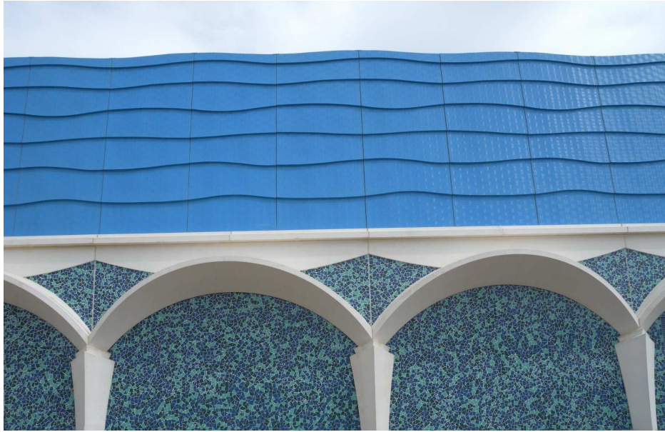
ODYSSEUM : Arches en béton blanc et panneaux bleus texturés forme de vague
